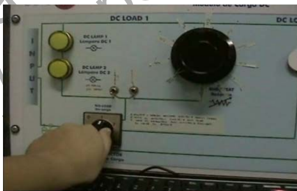
Imagen 8. Colocación del selector de carga en la posición 1. (Paneles operando en circuito abierto)
